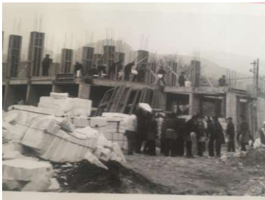
Lucrărilor de construcție a noului sediu al Școlii din Cîmpeni. (Fotografie din arhiva domnului Culda Adrian)
