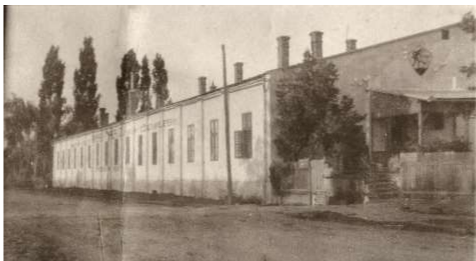
Clădirea principală a Firmei Ambrosi-Fischer & Co., anii '30
