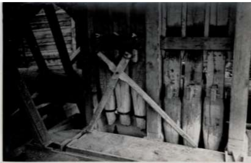
Săgeți de șteampuri din bazalt de la Detunata și pivele lor.
