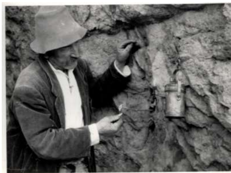
Aprinderea fitilului pentru pușcarea găurilor cu dinamită sau astralită.
