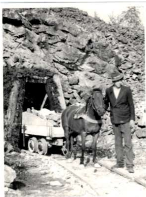
Scoaterea minereului cu calul cu râznă pe șine din lemn.
