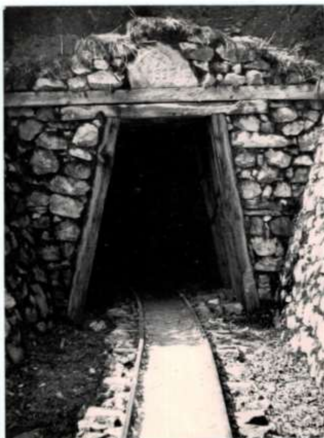
Intrare într-o galerie cu susținere din lemn și șine din fier.
