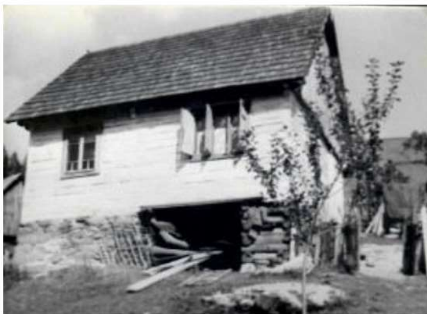
Casa familiei Lazea Traian și Teodora în anul construcției 1957, Scărișoara. (Fotografie din arhiva doamnei Jurj Olga)
